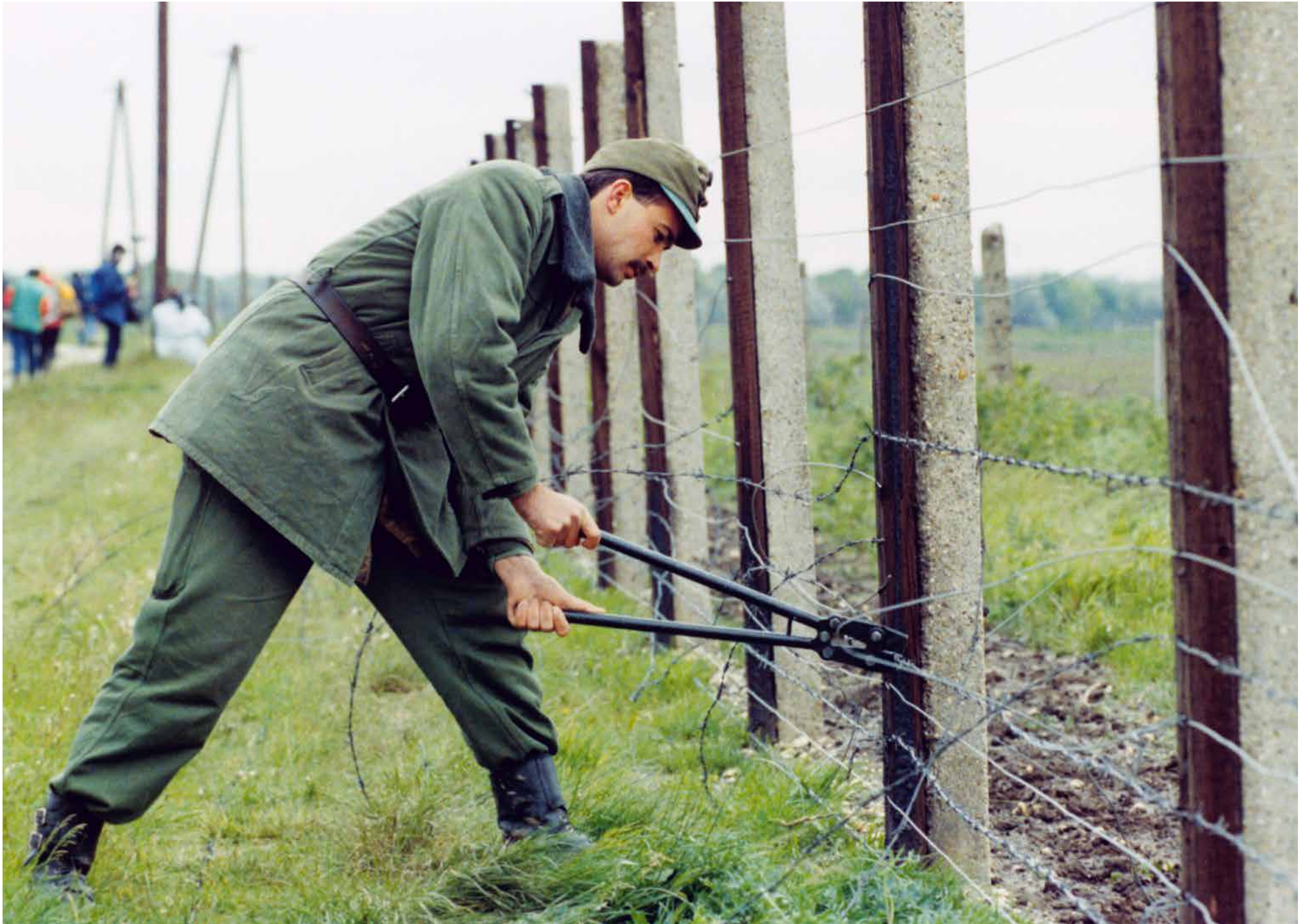
Demontage des Grenzzauns nahe Nickelsdorf und Hegyeshalom Foto: © picture-alliance/dpa
